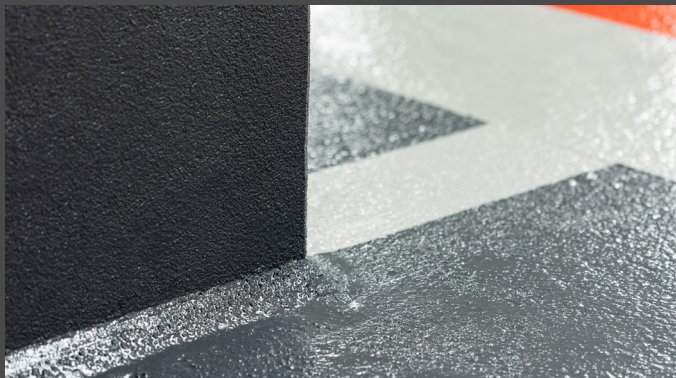
Beschichtung Sockelbereich
