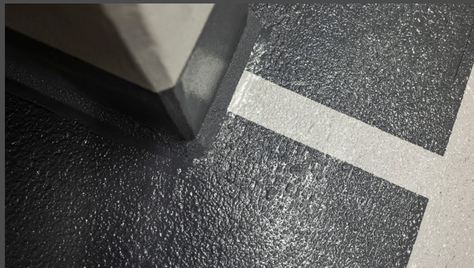
Parkflächen Stützen & Sockelanschluss
