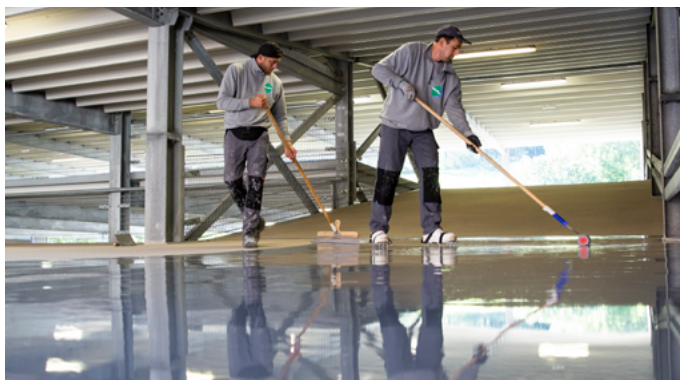
Manuelle Verarbeitung der Abdichtungsmembrane
