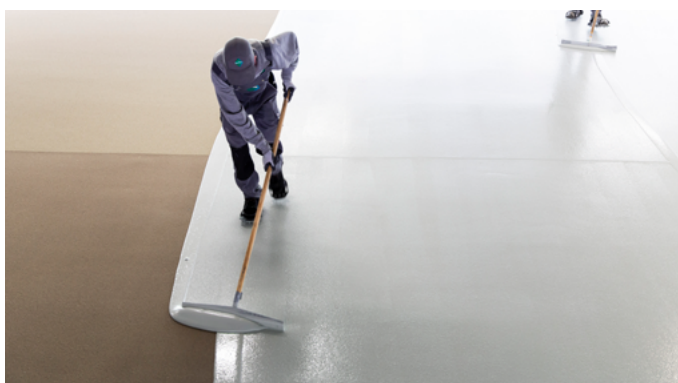
Beschichtung im Zwischengeschoss
