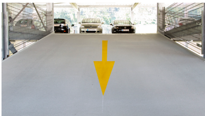
Die Rampe mit OS 8 beschichtet
