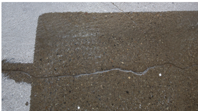
Vorbereitung durch Verschließen der Risse
