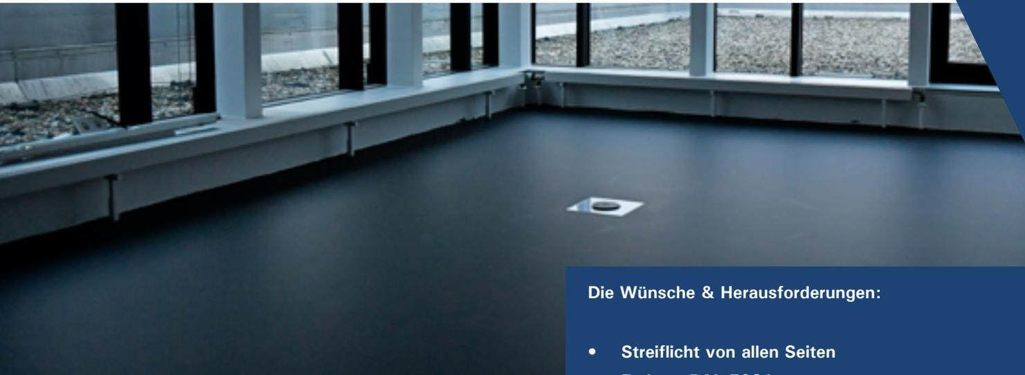
Auf die abgestreute Oberfläche kam ein Porenverschluss VIASOL PU-C525 mit ca. 0,8kg/m<sup>2</sup>. Dieses hochelastische Material gleicht Unebenheiten aus und schließt kleine Poren an der Oberfläche.
